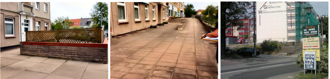
2. BA Bahnhofstraße vor der Maßnahme
