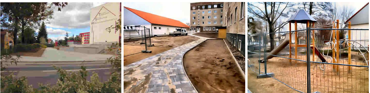
2. BA Bahnhofstraße kurz vor Fertigstellung
